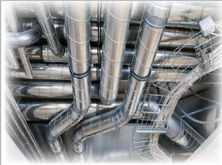
Conduits circulaires spiralés ou lisses
